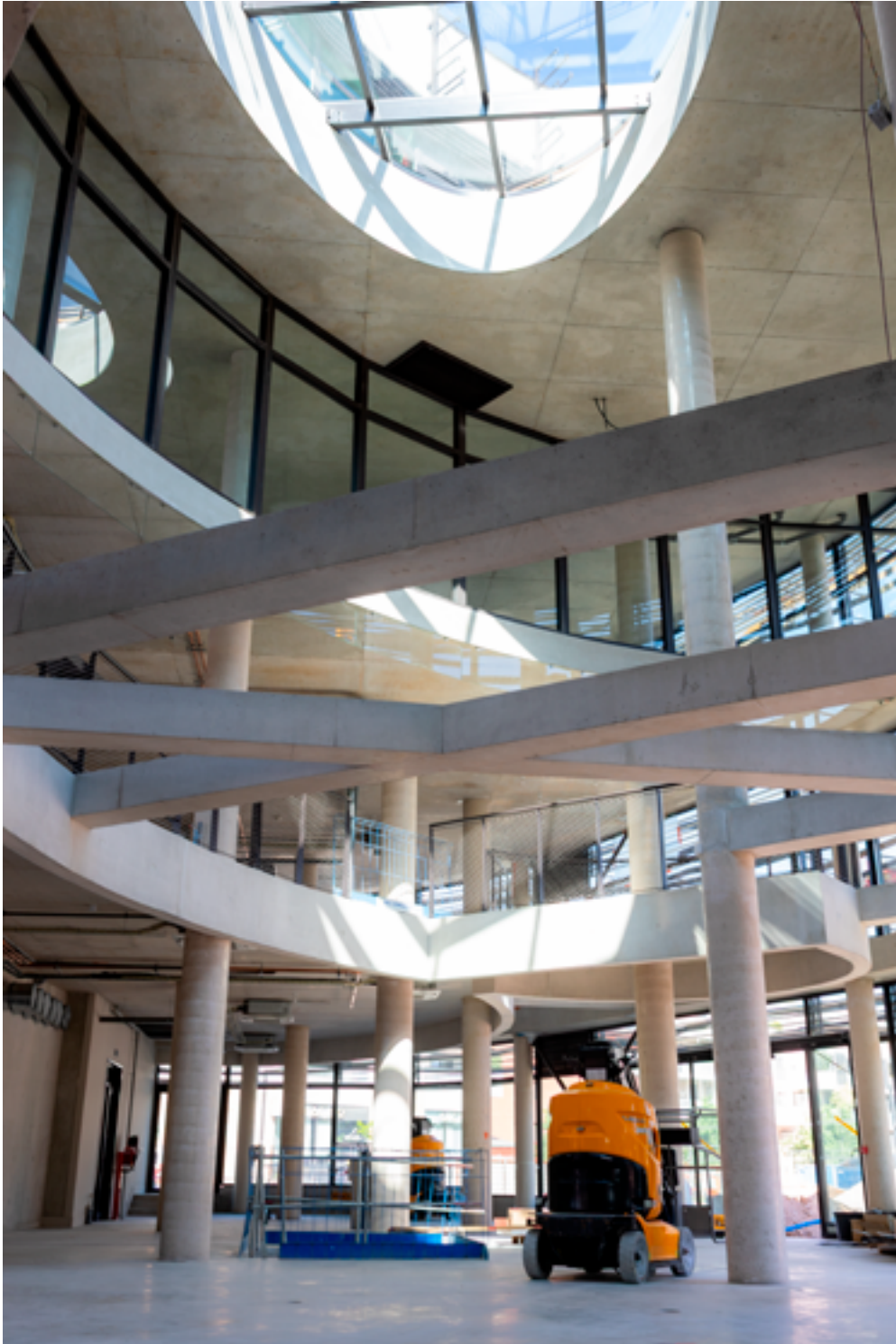
Les Halles Védasiennes vue du rez-de-chaussé vers la fin des travaux en mai 2025. Un espace spacieux et lumineux qui accueillera 22 étaliers sur deux étages dès septembre 2025.
