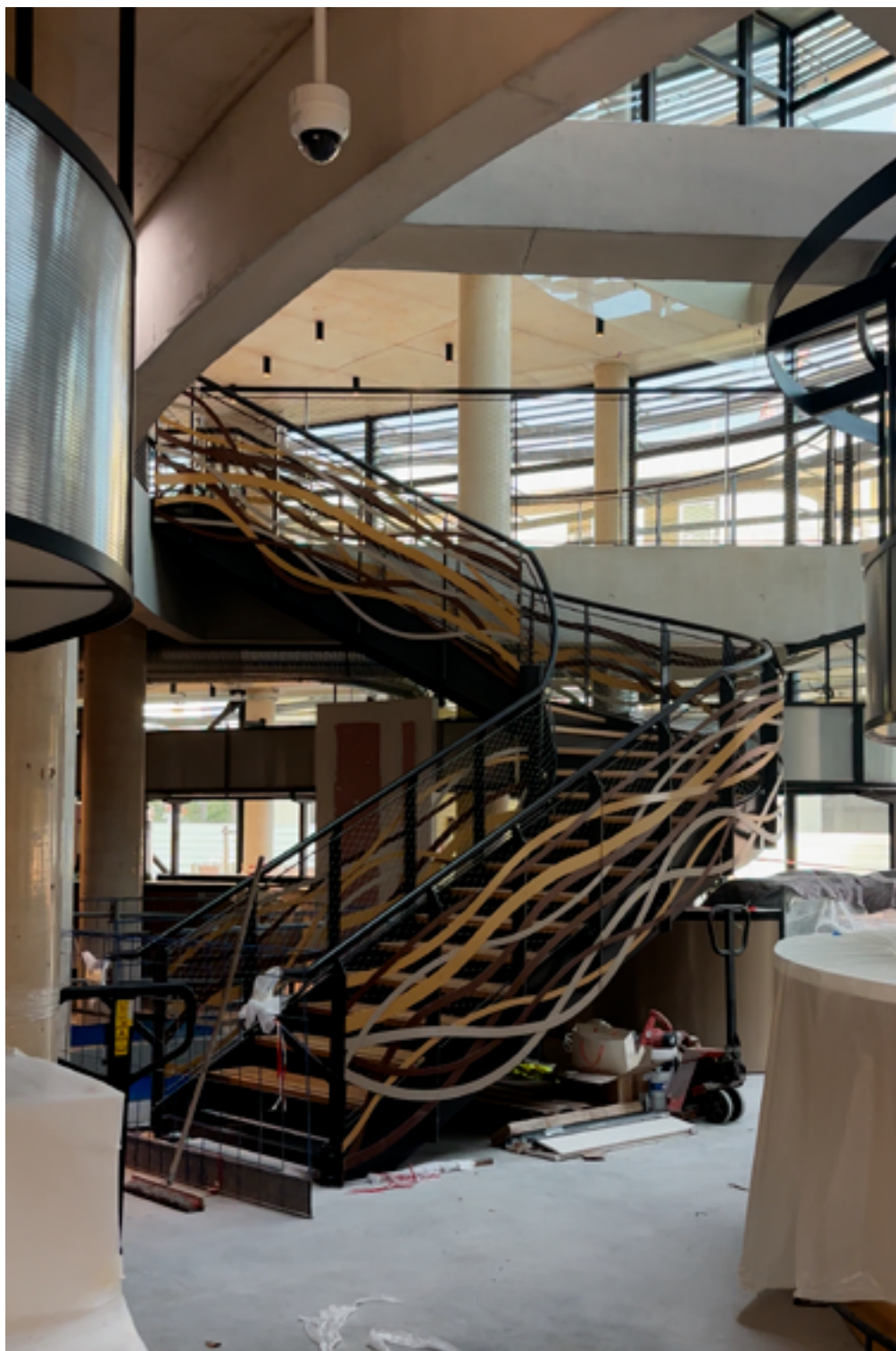
Escalier du rez-de-chaussé menant au premier étage des Halles Védasiennes en cours d'installation. Conception Maguelone Vidal, réalisation et pose Cros & Delmas. Août 2025.
